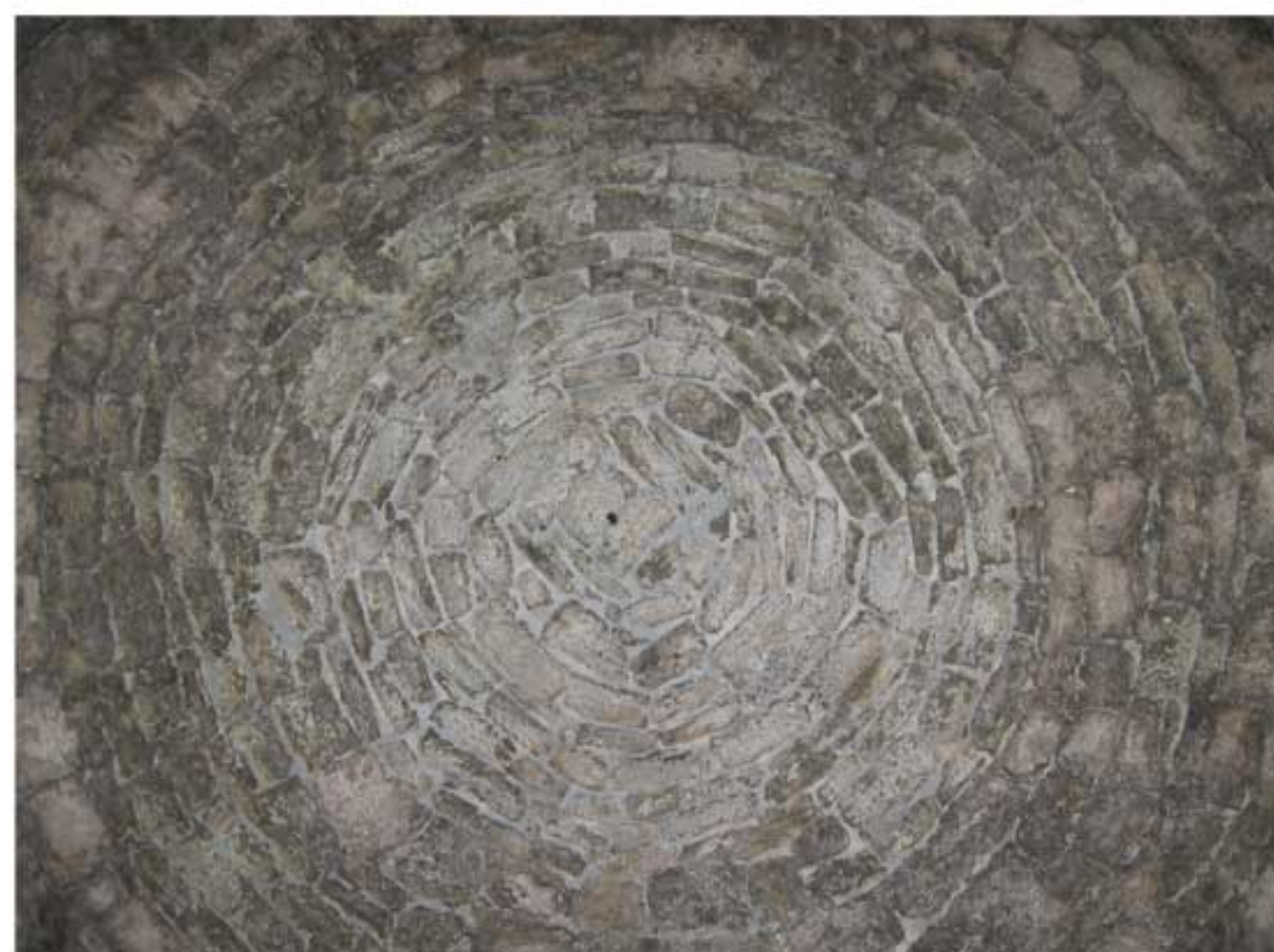
l'intervento di restauro
